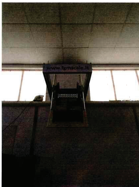
Foto 4: verifica integrità meccanismo apertura-chiusura
