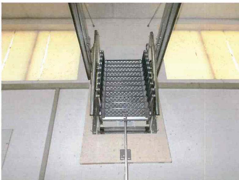
Foto 4: verifica integrità meccanismo apertura-chiusura
